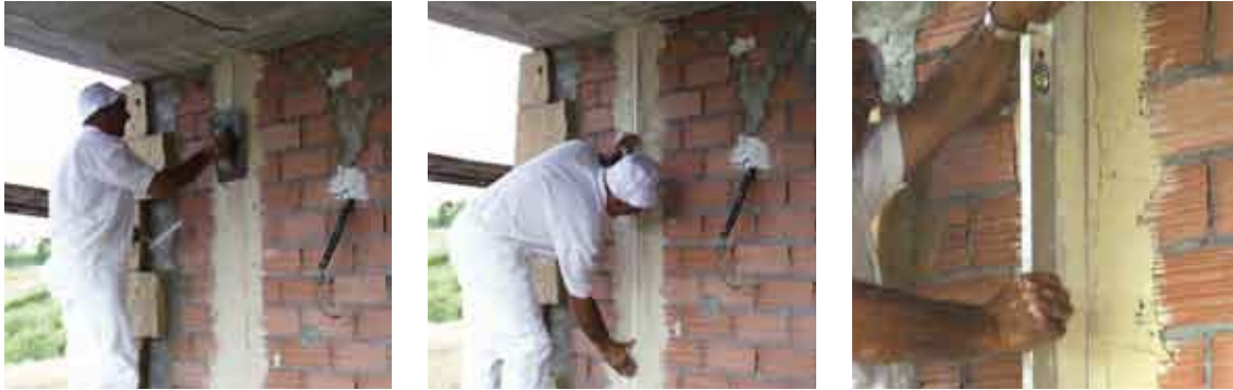
22. Colocación de los junquillos (extendido de la pasta, colocación y aplomado o nivelado).
