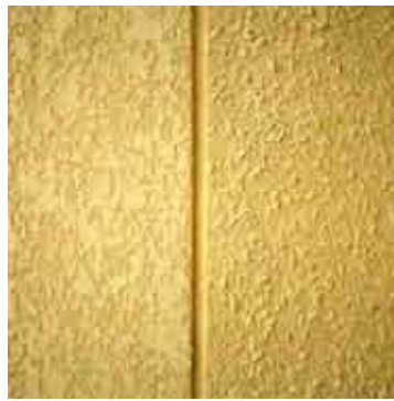
8. Acabado planchado también denominado chafado o aplastado (izquierda) y gota (derecha).
