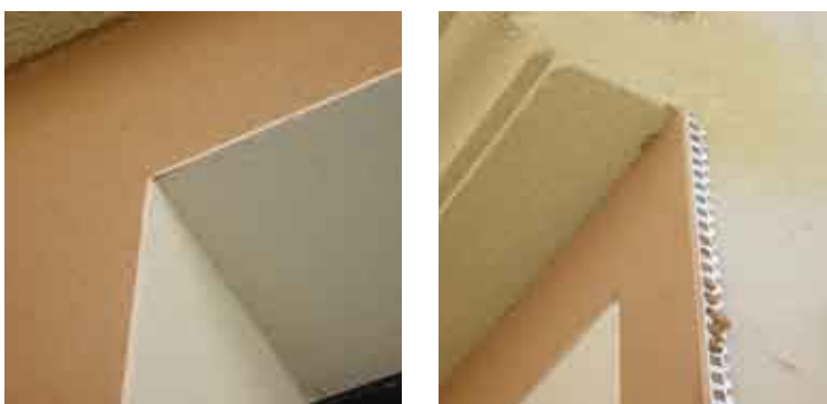
19. Detalle de colocación de guardavivos y cantoneras.
