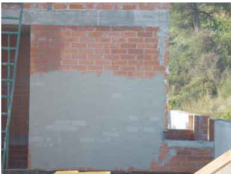
25. Fachada con la aplicación de una primera mano de monocapa para homogeneizar la superficie.
