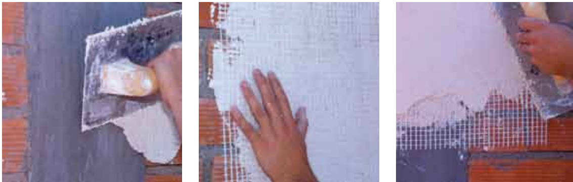
17. Detalle de colocación del monocapa con cambio de material en el soporte.
