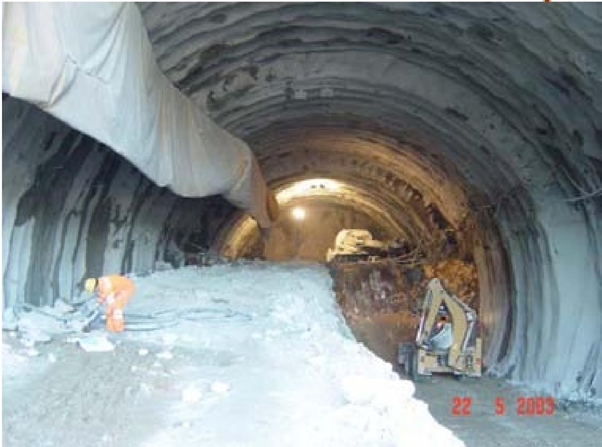
Este paraguas empotró claramente en granito masivo, lo cual se comprobó desde el primer momento pues el rendimiento en la ejecución fue de la mitad que en los anteriores. Se dio por terminada la operación bajo la A-6 y se continuó la ejecución del túnel según lo inicialmente previsto.
