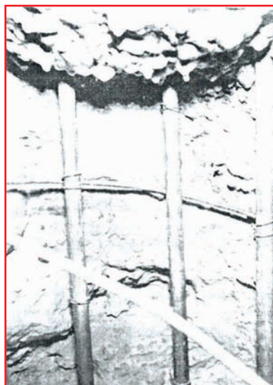
Fig. 14. Ejemplo de fondo de pilote donde se presentó acumulación de limos previa al hormigonado. (Thorburn, S., 1977).
