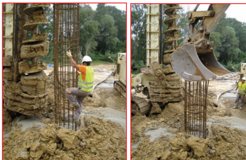
Fig. 39. Colocación forzada de armadura en un pilote tipo CPI-8.
