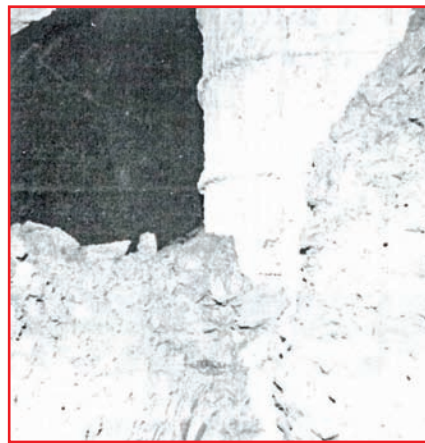
Figs. 28 y 29. Efecto de la entrada de agua en un pilote. (Thorburn, S., 1977 y Fleming, K., 2008).
