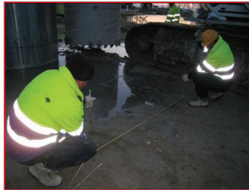
Fig. 7. Ejemplo de replanteo en eje de pilote.
