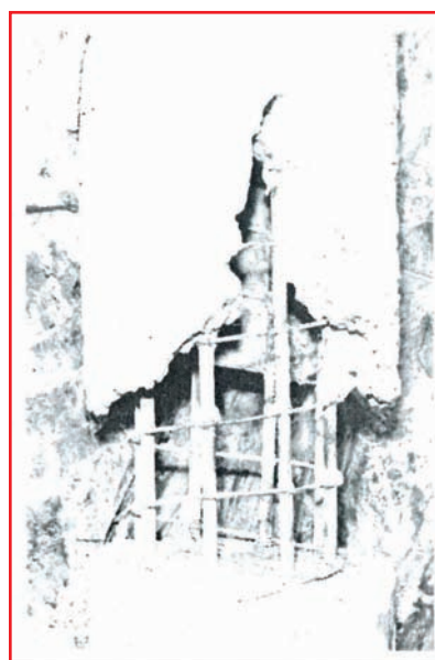
Fig. 10. Discontinuidad en pilote por existencia de gran cavidad. (Thorburn, S., 1977).
