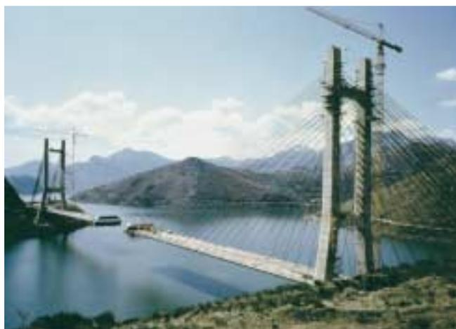
Fig. 3. Construcción del puente de Barrios de Luna.
