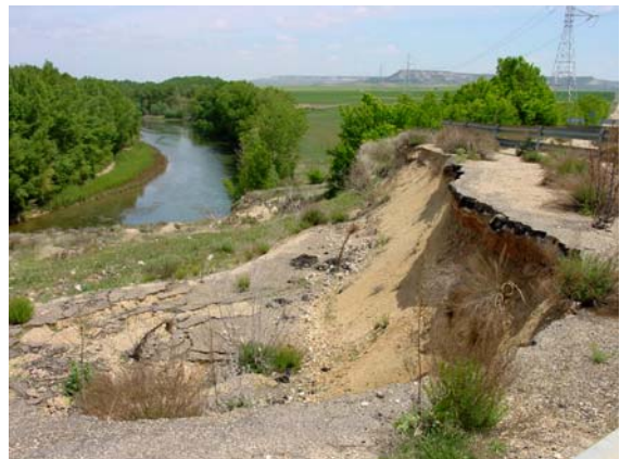
Fotos 4 y 5. Detalles del deslizamiento actual de Reinoso de Cerrato
