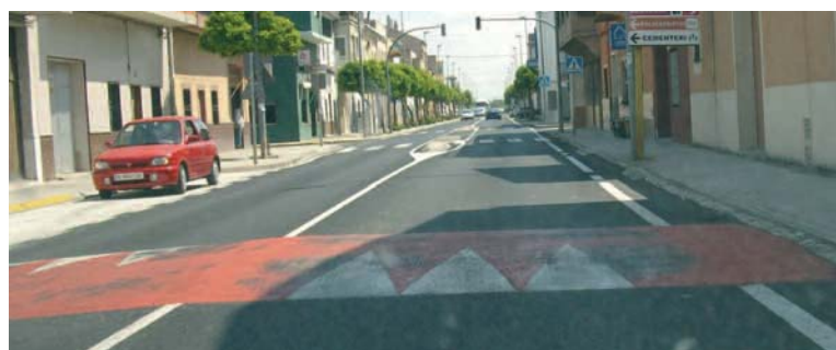
Existen aceras en ambos lados. Los peatones cruzarán por aquí confundiendo con un paso de peatones.
