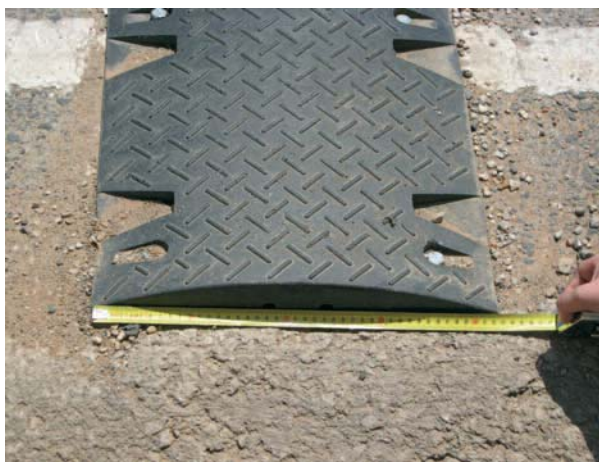
RDV prefabricado de altura 5 cm y anchura 42 cm. Se produjeron frenazos bruscos de los vehículos y hubo que retirarlos por la peligrosidad de los alcances.
