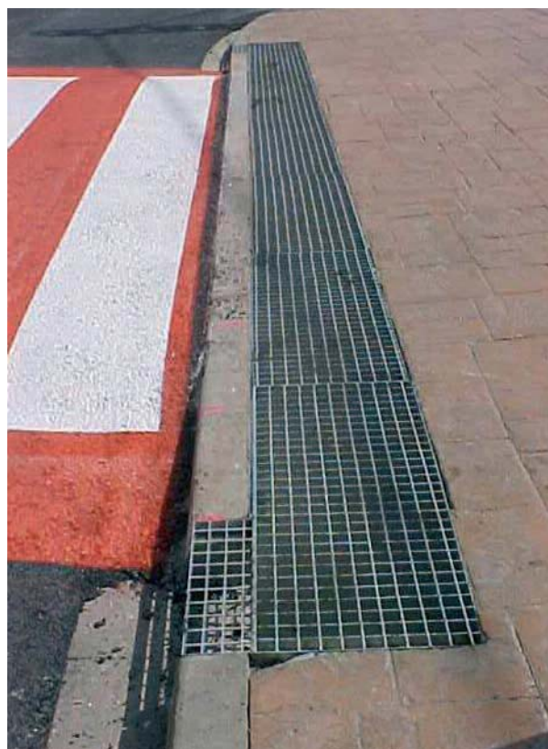
Drenaje y accesibilidad bien resuelto.
