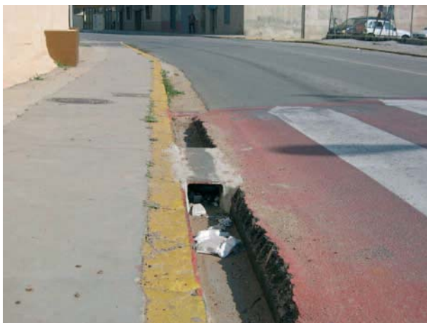
Drenaje mal resuelto. El paso es una “trampa” para personas con movilidad reducida.
