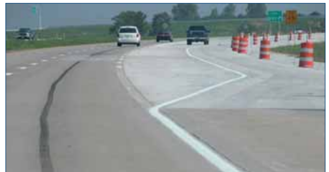
Figura 8. Marca vial de separación de carril de deceleración con discontinuidad en I-65 (Fair Oaks, Indiana, EE. UU.)
