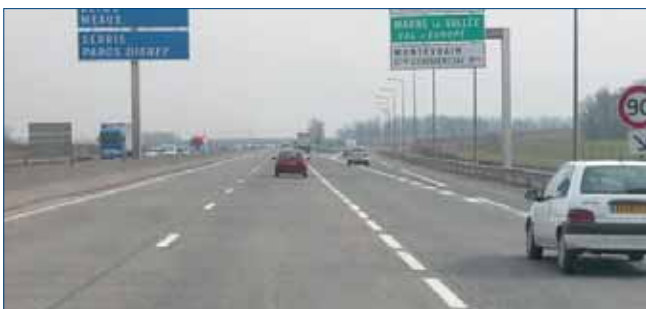
Figura 6. Marca vial de separación de carril de deceleración sin discontinuidad (Marne-la-Vallée, Francia)
