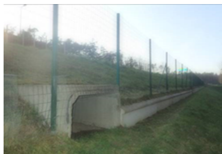
Photos 38 à 40 : A gauche, tunnel sous chaussée de type II b (batrachoduc de Gaumont) ; Au centre, tunnel sous chaussée de type II b (batrachoduc de Soufflenheim) ; A droite, tunnel sous chaussée de type II c (Molsheim) (Source : © A. Morand, Cerema Est)
