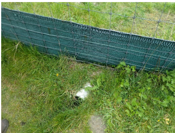
Photo 47 et 48 : Une buse perpendiculaire au pied d'une clôture renforcée sur le dispositif temporaire de la Dune de Slack Dpt du Pas de Calais (Source : © A. Morand, Cerema Est) ; A droite, un aménagement conséquent « drain-fossé » pour évacuer les eaux sur le site d'Esh-Belval (dpts 54/57) (Source : © A. Morand, Cerema Est)
