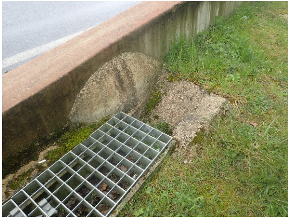
Photos 45 : Batrachoduc du lac de Der : une rampe à pente douce (Source : © A. Morand, Cerema Est)
