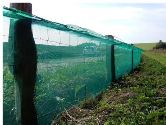
Photo 24 : Dispositif avec bavolet sur le chantier de la RN4 à Heming (Source : © A. Morand, Cerema Est)
