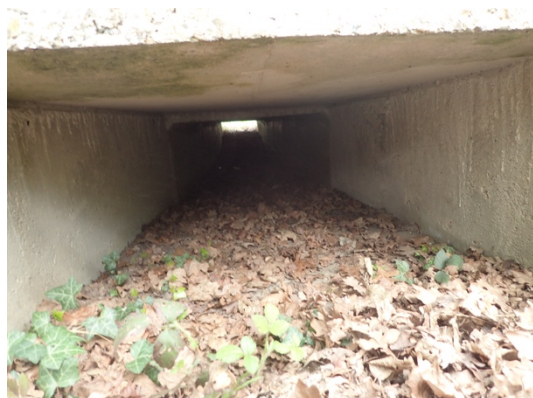
Photo 43 et 44 : Lumière au bout du tunnel et substrat végétalisé naturellement dans le conduit, respectivement sur le batrachoduc de Sorques (77) et celui de l'étang de Laurêre (25) sur la RD 14 (Source : © A. Morand, Cerema Est)
