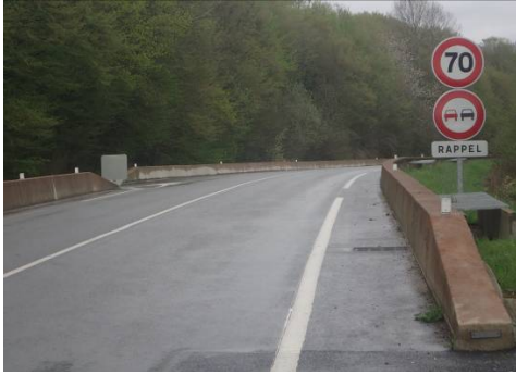
Photo 32 : Installation standard ou collecteur en L préfabriqué en béton avec une petite corniche en béton. Source : Le Lac du Der (Source : © A. Morand, Cerema Est)
