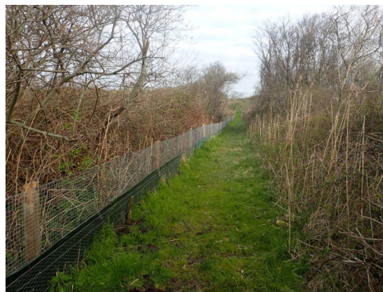
Photo 22 : Un exemple de dispositif quasi-pérenne sur la RD 940 - dunes de Slack et site du Conservatoire (Atelier Chantier Insertion Rivages Propres & Eden 62) : barrière permanente d'une centaine de mètres des deux côtés de la voie (RD 940) avec collecte des amphibiens 6/12 mois (Source : © A. Morand, Cerema Est)
