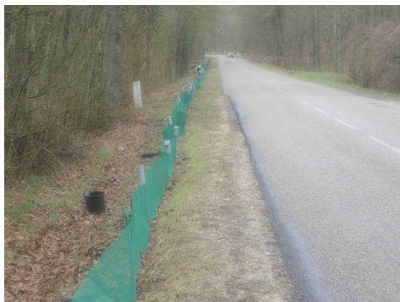
Photo 21 : Un dispositif temporaire, installé seulement du côté de l'habitat terrestre (ici une forêt), qui bloque pendant quelques semaines le déplacement des amphibiens en sortie hivernale et migration prénuptiale (RD 71) en direction de l'étang - Il est recommandé de ne pas implanter les piquets du côté d'où arrivent les amphibiens (Source : © A. Morand, Cerema Est)
