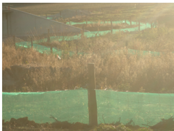
Photo 23 : Dispositif avec bavolet sur le chantier de la voie rapide de Pierre-Villers (Source : © A. Morand, Cerema Est)
