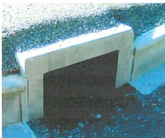
Photos 41 et 42 : A gauche, passage de type IIb avec cadre ouvert en béton) ; A droite, avec cadre ouvert en mini-tunnel (l=0.50 m) (Source : Maibach)
