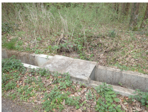
Photo 30 : Collecteur standard en U des installations de type IIa (béton préfabriqué avec couvercle, bavette, fosse de capture). Ils sont, par leur poids et leur stabilité, durables. Leur efficacité est reconnue (supérieure aux collecteurs en L) mais les difficultés de mise en œuvre et d'entretien sont suffisamment importantes pour que ce dispositif soit peu à peu remplacé par les murets de collecte (Source : PNR Gâtinais français, marais de Larchant ou d'après [69])
