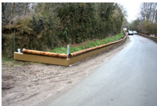
Photo 36 : Barrière mixte : glissière de sécurité en bois et tablier métallique pour protection des motards à Condé sur Vesgre (dpt 78) (Source : © ATENA 78)
