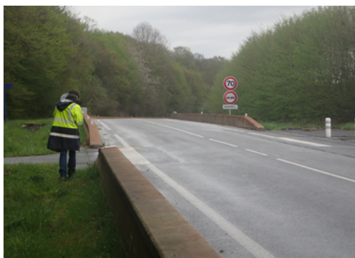
Photos 49 et 50 : Mur Véhicule Léger en bordure de chaussée A gauche, Batrachoduc du lac de Der ; A droite Batrachoduc de Gaumont (dpt 57) (Source : © A. Morand, Cerema Est)
