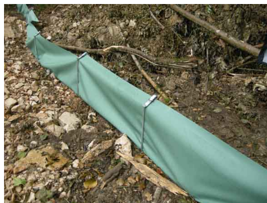
Photos 19 et 20 : Un exemple, en cours de montage sur la voie RN 57 des Mercureaux (en 1999) de « kit » de dispositif de protection temporaire qui comprend une bâche polyester de 50 cm de large, des piquets ajustables en hauteur, des éléments de fixation coudés (45°) en partie supérieure pour former un bavolet infranchissable à placer tous les 2 m (Source : © M. Gigueux, Cerema Est)
