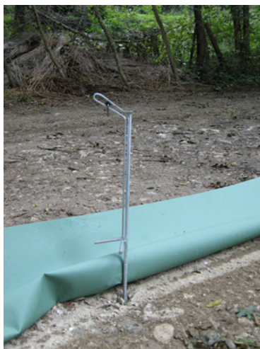
Photos 19 et 20 : Un exemple, en cours de montage sur la voie RN 57 des Mercureaux (en 1999) de « kit » de dispositif de protection temporaire qui comprend une bâche polyester de 50 cm de large, des piquets ajustables en hauteur, des éléments de fixation coudés (45°) en partie supérieure pour former un bavolet infranchissable à placer tous les 2 m (Source : © M. Gigueux, Cerema Est)
