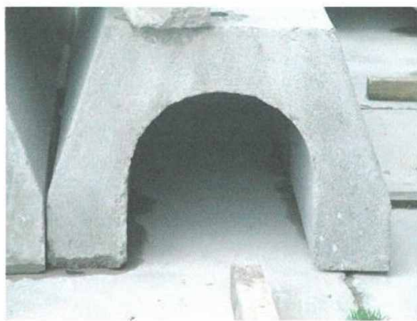
Photos 41 et 42 : A gauche, passage de type IIb avec cadre ouvert en béton) ; A droite, avec cadre ouvert en mini-tunnel (l=0.50 m) (Source : Maibach)
