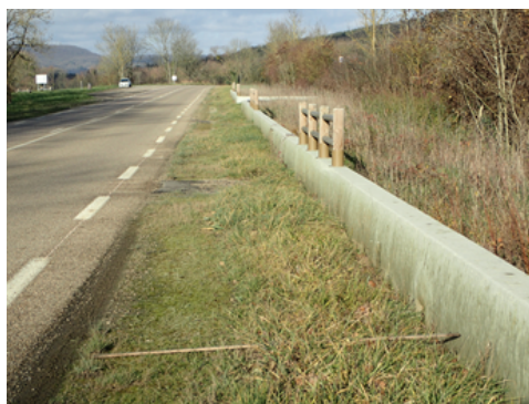
Photos 49 et 50 : Mur Véhicule Léger en bordure de chaussée A gauche, Batrachoduc du lac de Der ; A droite Batrachoduc de Gaumont (dpt 57) (Source : © A. Morand, Cerema Est)
