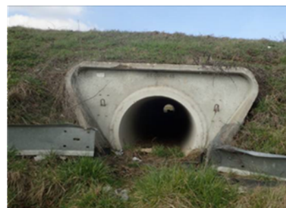
Photos 38 à 40 : A gauche, tunnel sous chaussée de type II b (batrachoduc de Gaumont) ; Au centre, tunnel sous chaussée de type II b (batrachoduc de Soufflenheim) ; A droite, tunnel sous chaussée de type II c (Molsheim) (Source : © A. Morand, Cerema Est)
