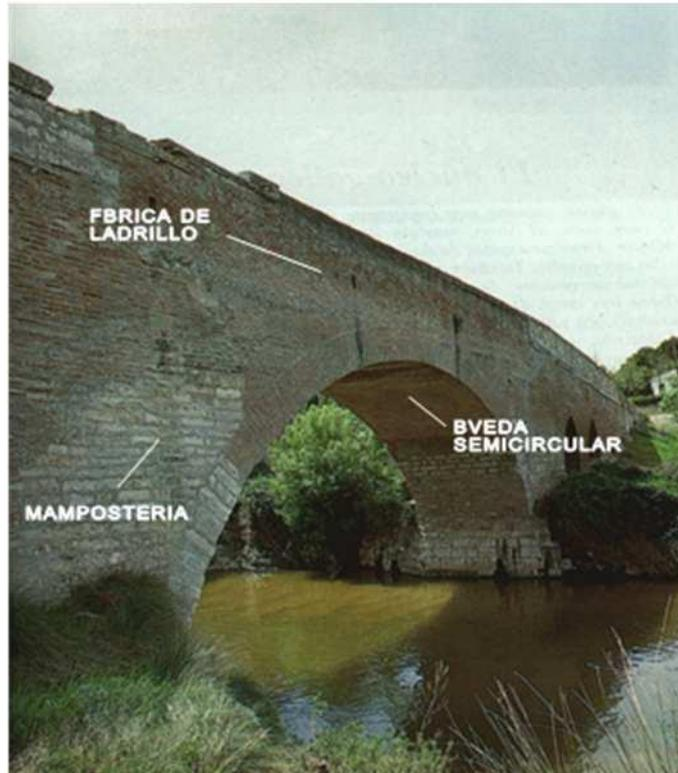
**Boquilla:** Arco que conforma y delimita el borde de las bóvedas de un puente. También se denomina de este modo al conjunto formado por los paramentos laterales o exteriores al cañón de un puente y las aletas o acompañamientos, incluso contrabóvedas y soleras extremas. Ver rosca.
