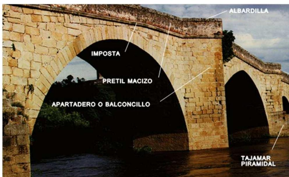
**Supestructura:** Parte del puente que incluye todos los elementos estructurales que conforman su franja superior, es decir: boquillas, bóvedas, tímpanos y rellenos.
