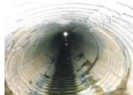
Figura 4. Tubo ovalizado por defecto en rigidez
