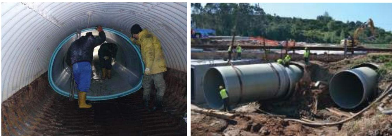
Figura 8. Relining con tubo de PRFV
