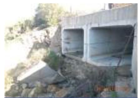
Figura 6. Rotura aletas en marco prefabricado
