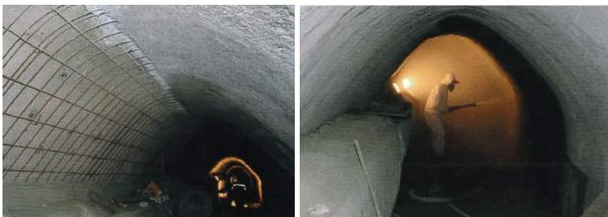
Figura 10. Rehabilitación ODT con hormigón proyectado
