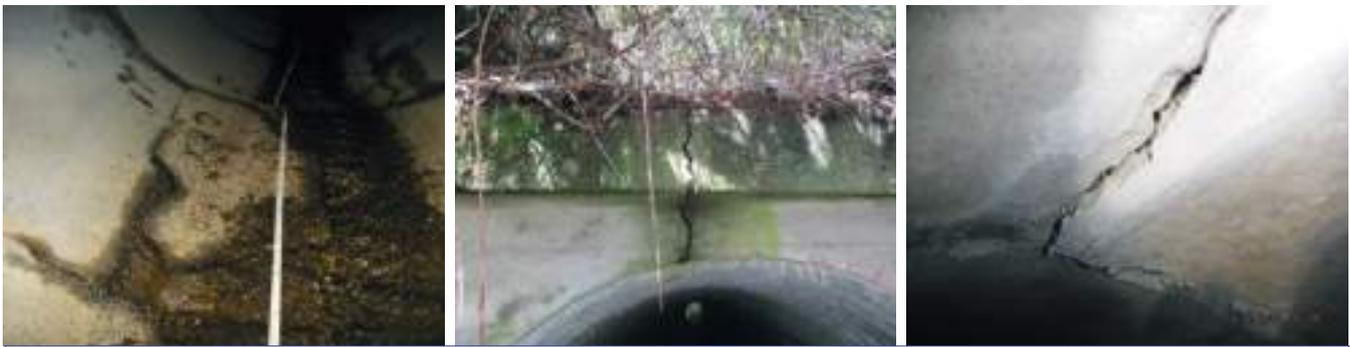
Figura 3. Tubos dañados por fisuración
