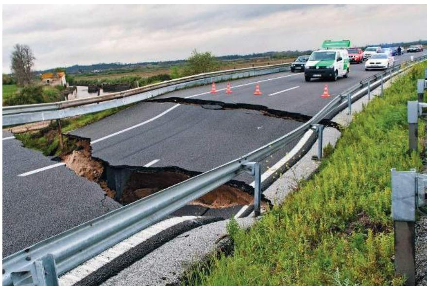
Figura 1. Autovía colapsada por fallo estructural de la ODT.
