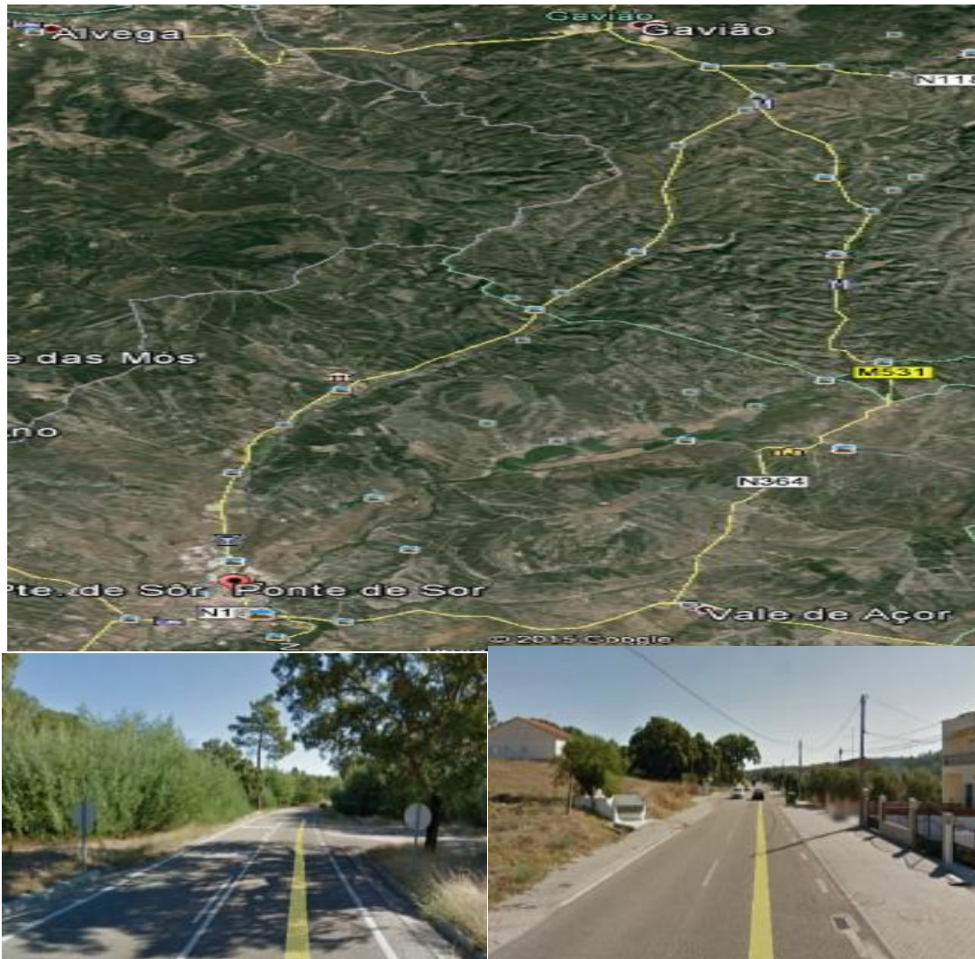
Figura 6.2-3 - EN244 – Obra de mejora Ponte de Sôr / EN118 (Portalegre), longitud 24.2 km de longitud
