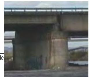
Fig 9 : Pile-Culée entre le pont d'accès et le pont principal. Voile commun sens + et -. La pile est en bon état.
