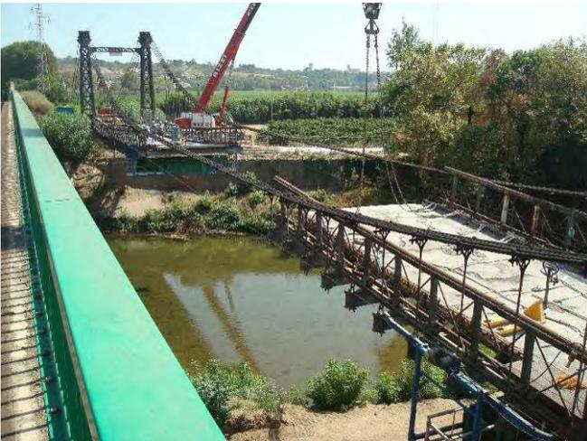
Ph 11 : Prise en charge par une des grue de rive d'un tronçon de dalle, les dalles sont morcelées et traitées in situ
