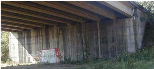
Fig 8 : Culée du pont d'accès. Voile commun sens + et -. La culée est en bon état. MAIS le recul du garde-grève est très insuffisant et ne permet pas de concevoir un nouvel about correct, sans reconstruire ce garde-grève.
