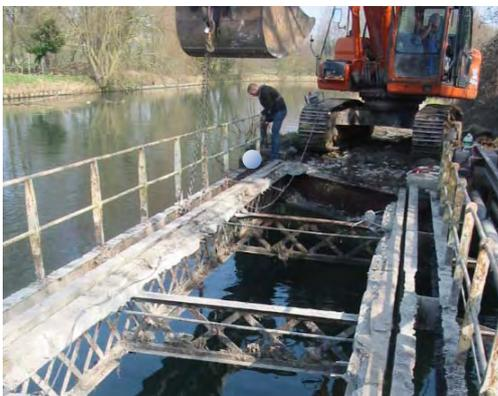
4. [ hors du marché de démolition ] : réfection des appuis en vue d'un nouveau tablier, pose du nouveau tablier en bois (structure et GC)
