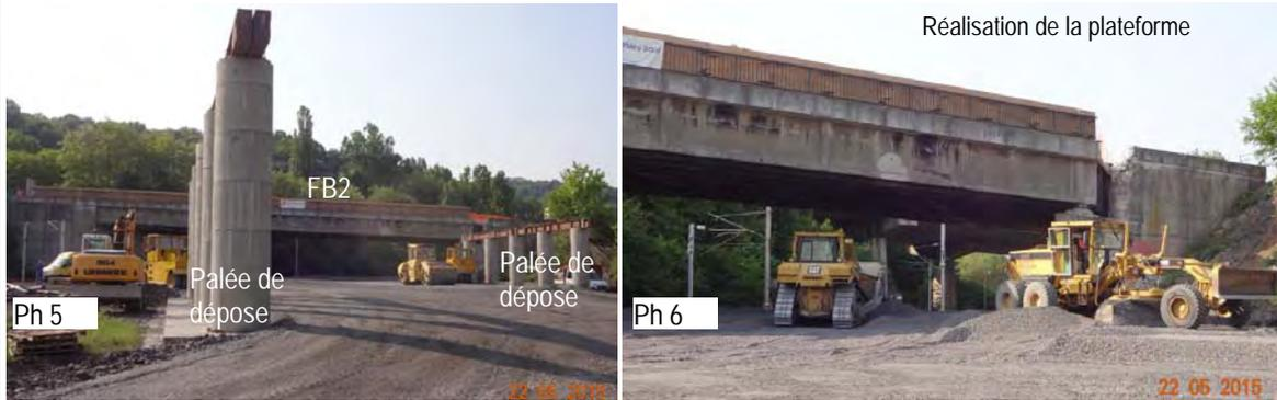
2. Coupure des voies électrifiées : - démontage rails et caténaires par SNCF. - Réalisation de la partie de plateforme. – Démolition de parties de culées VF Elec. côté Morsbach. 3. Déplacement et mise en place des kamags. L'ouvrage à lever pèse 1400 t.
