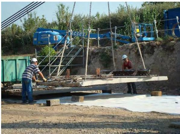
Ph 9 : Mise en place des 4 chevêtres de vérinage (HEA100) sur le dessus des pdp. Vérinage en 4 points
