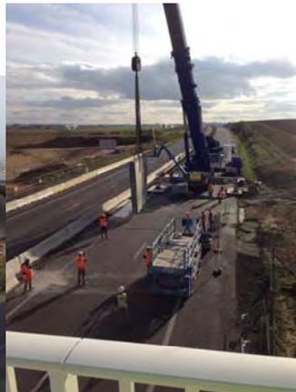
5. la priorité du chantier étant de limiter au maximum les risques et la gêne occasionnée aux usagers de l'autoroute, la solution retenue a privilégiée le découpage des éléments de ponts en tronçons lourds afin de limiter leur nombre. Aucun étaieage provisoire n'a été mis en place du fait de l'élingage des éléments de tablier avant sciage.
