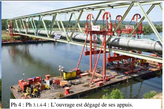
Ph 4 : Ph 3.1.4-4 : L'ouvrage est dégagé de ses appuis. Il est descendu par les vérins à câbles.
