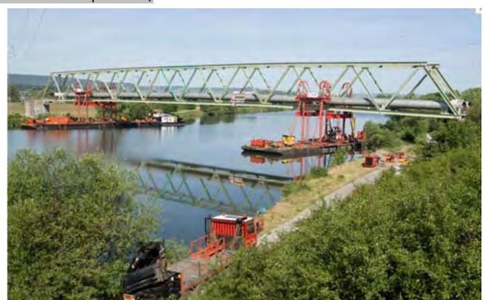
Ph 2 : Traverses hautes, l'ouvrage est soulevé de ses appuis. Il commence à être déplacé.
