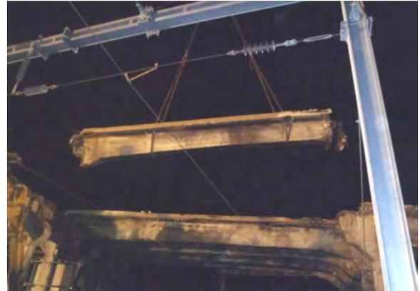
NB : Avant de s'attaquer aux travées au-dessus des voies ferrées, l'intervention avait débuté par la dépose des poutres de la travée intermédiaire (T4). Cela avait pour objectif de se familiariser avec le procédé et de bien définir la cadence d'avancement avant d'intervenir sur les zones sensibles.
