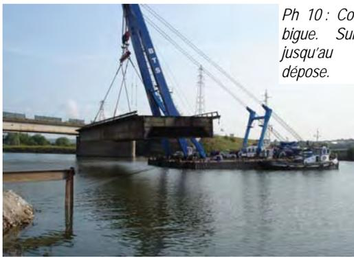
Ph 10 : Colis levé par la bigue. Suite du trajet jusqu'au portique de dépose.
