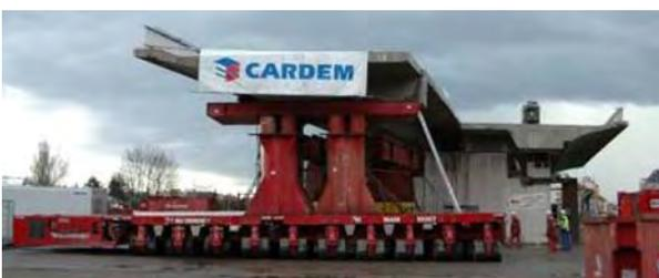
ph 5 : délançage. Vue coté terre, coté de la palée sur kamags. On observe les rails de roulement qui sont passés par les fenêtres réalisées dans la pile
