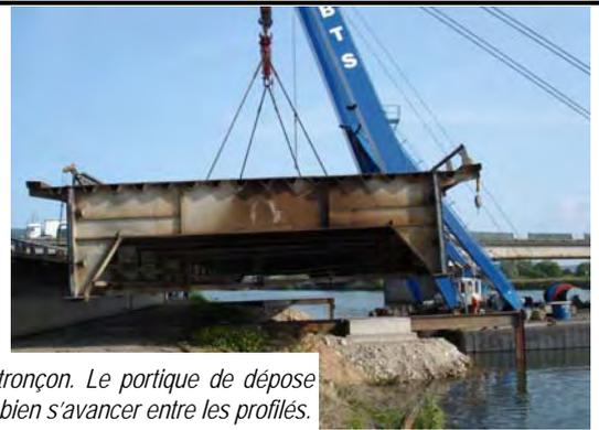
Ph 11 : Dépose du tronçon. Le portique de dépose permet à la bigue de bien s'avancer entre les profilés.
