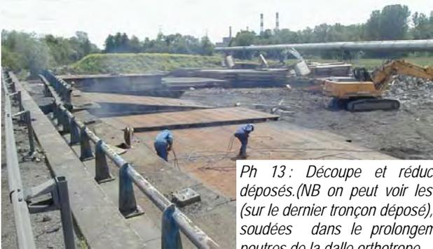
Ph 13 : Découpe et réduction des Tronçon déposés. (NB on peut voir les oreilles de levage (sur le dernier tronçon déposé), oreilles spécifiques soudées dans le prolongement de l'âme des poutres de la dalle orthotrope.
