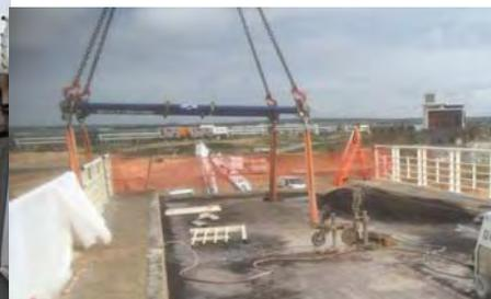
3. réalisation de carottages pour l'élingage de la pile de rive, mise en place des élingues, puis sciage de la pile 5 cm au-dessus du niveau de la chaussée. Extraction de la pile vers la plate-forme de déconstruction pour broyage.
