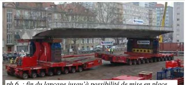
ph 6 : fin du lançage jusqu'à possibilité de mise en place d'une deuxième palée, puis transport sur aire de démolition
