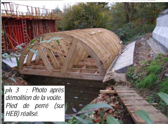
ph 3 : Photo après démolition de la voûte. Pied de perré (sur HEB) réalisé.
