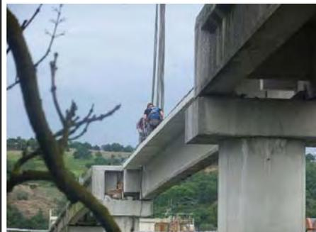
4. Levage et dépose des tronçons de tablier (poids unitaire 46 tonnes)
