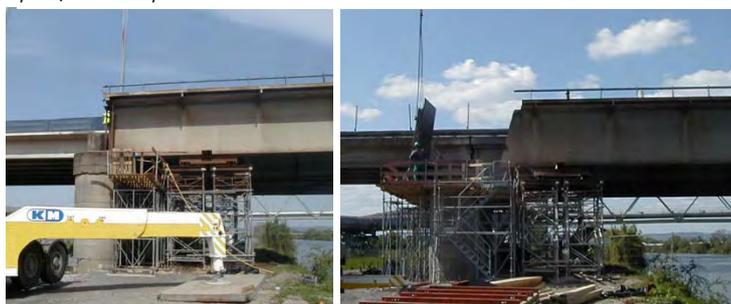
**2) enlèvement des tronçons de tabliers** Les tronçons seront enlevés dans l'ordre suivant : tronçon RD (191 t), tronçon RG (191- 6) t, tronçon central (220 t) (voir ci-dessous les photos de l'enlèvement du tronçon central). Cf § « délai », un enlèvement de tronçon sera effectué par jour soit un total de 3 jours calés pendant les 10 jours annuels de chômage programmés de la Moselle.
