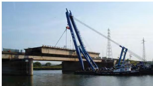
Ph 9 : Colis levé par la bigue. Recul et début du trajet jusqu'au portique de dépose.
