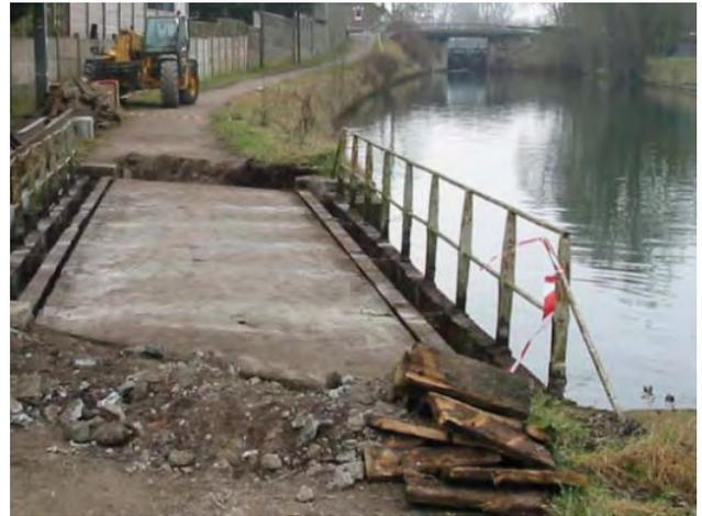
2. Mise en place d'une structure métallique - support et guide - en vue du sciage de la dalle par plots. Enlèvement des plots.
