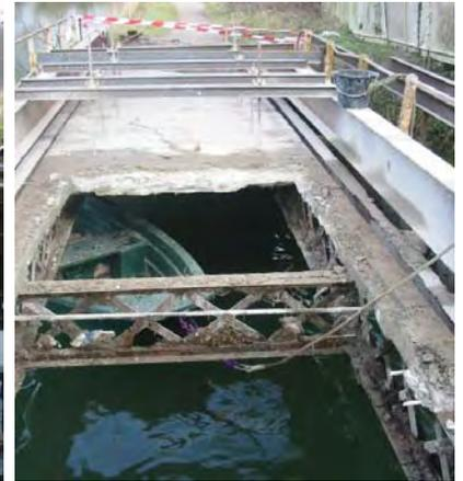
3. Enlèvement de la structure métallique de soutien précédente. Grutage de l'ancienne par éléments (pièces de pont, demi poutre) et enlèvement de ceux-ci.
