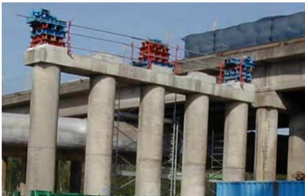
Fig 19 : pile type du pont d'accès. Photo du réaménagement de tête. NB les camarteaux sont en attente de l'ossature 5 poutres (qui pour le lancement ne s'appuie que sur 3 poutres).
