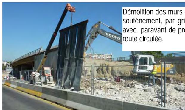
Démolition des murs en Té de soutènement, par grignotage, avec paravant de protection / route circulée.
