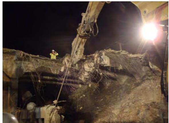
L'objectif étant que tous les matins, à la remise en service des voies ferrées, aucun élément de l'ouvrage ne doit rester en porte-à-faux ou en équilibre précaire. De plus, la stabilité du reste de l'ouvrage, lors de ces phases intermédiaires, est justifiée par le calcul.
