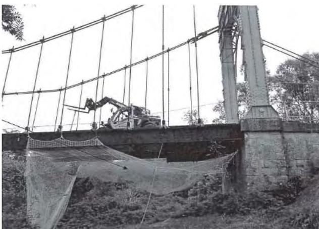
2. Découpe des trottoirs de l'ouvrage par éléments de 1m est réalisé depuis la culée en rive droite en revenant vers la culée rive gauche. Un engin type manuscopique charge les éléments et les stocke en benne avant évacuation au centre de traitement.
