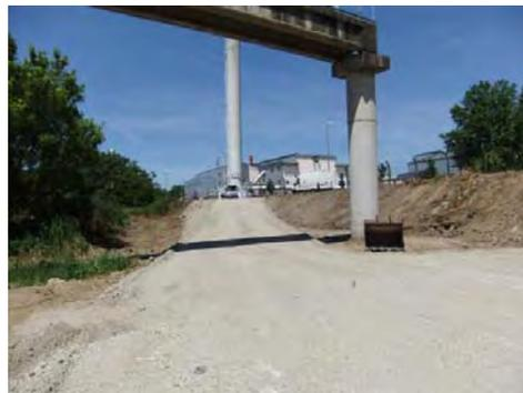
2. Aménagement du gué pour démolition des piles (1 700 tonnes d'enrochement)
