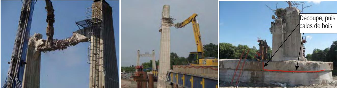
\*démolition des culées (avec souci d'un canalisation de gaz au pied) : Détente des barres précontraintes (8 par culées, 16 par piles) au vérin creux, pré-sciage à la scie pour ne pas détruire la maçonnerie, utilisation d'un BRH depuis l'arrière de la culée avec contrôle des vibrations sur la canalisation d'oxygène AIR LIQUIDE, finition à la fraiseuse hydraulique (pas de vibration).
