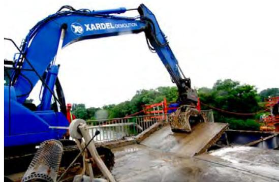
\*Découpe à partir de nacelle des éléments d'ossature évacués depuis une grue sur le remblai de rive. (grue de 200t puis 160 t)
