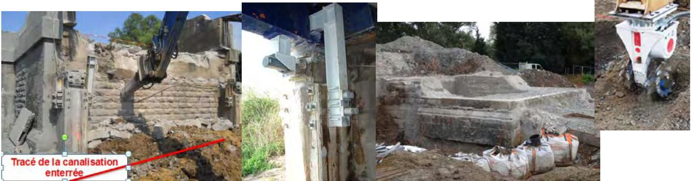
5. \* (entamé avant) renforts en sous-cœuvre des fondations (micropieux en culée, injections pour les pylônes)
