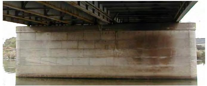
Fig 7 : Pile Dalle orthotrope (pont principal). La pile est un voile commun au sens + et -. On comprend qu'il n'est pas envisageable de faire une autre pile juste pour le sens +, et ce dans le lit mineur et navigué de la Moselle. Les piles sont en bon état.
