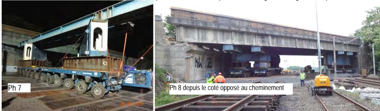
4. Mise en charge partielle des kamags (33% du poids du tablier) et démolition des appareils d'appui fixes sur la culée Morsbach (section rétrécie Freyssinet avec broches). Vu la géométrie difficile et exigue d'about, ces appareils d'appui furent plus longs et difficiles à démolir que prévus (ph9). 5. Prise en charge totale (levage des vérins des essieux) et déplacement du tablier par les kamags (ph 10)
