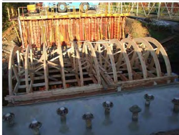
ph 4 : Micro-pieux de la nouvelle culée, avec ici bétonnage de la semelle d'appui de la nouvelle culée.
