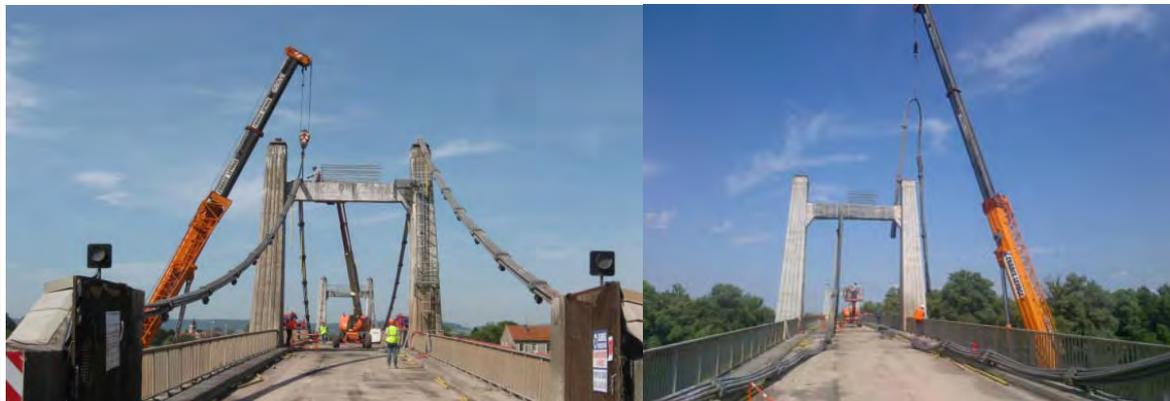
\*Démolition du tablier depuis le milieu et symétriquement, découpe par plots à la scie de la dalle (évacuation (les connecteurs étaient très affaiblis) en blocs de 4 tonnes : →Aspiration des eaux de sciage + Mise en place d'un géotextile drainant pour les eaux non aspirées. Prise en charge et évacuation des blocs à l'extérieur de l'ouvrage à l'aide d'une pelle 20 tonnes équipée d'une pince. (Limitation des charges admissibles de chantier à 20 tonnes due à la travée isostatique)
