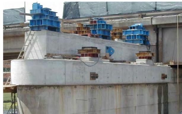
Fig 20 : Pile-culée. La pile a été démolie et refaite à parti du haut du fût. NB les camarteaux en attente d'un côté pour l'ossature 5 poutres (lancement sur 3 poutres.) et de l'autre côté pour l'ossature bi-poutre (2 appuis).
