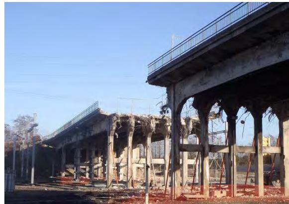
3. A l'avancement de la dépose des poutres au-dessus des voies électrifiées, les piles et la travée adjacente (travée d'accès hors emprise SNCF), sont démolies par grignotage.
