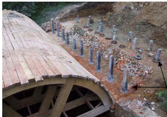
ph 2 : Photo après démolition de la voûte (cf : HEB de renforts pied de maçonnerie au premier plan et micropieux en arrière pour la nouvelle culée)
