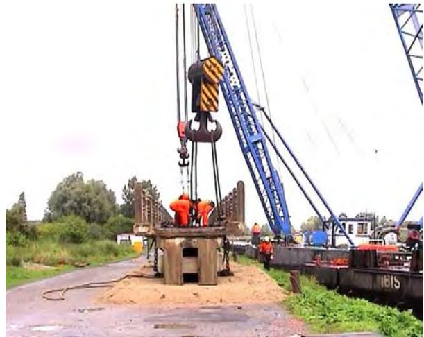
4. le tablier est réduit et les déchets de démolition évacués vers une plateforme de recyclage de déchets de démolition du BTP.
