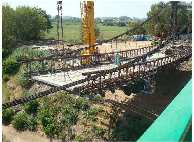
Ph 12 : Les haubans (présence d'amiante dans la protection anti-corrosion) sont découpés par des personnes habilitées et protégées en morceaux de 2m et mis en sacs étanches.
