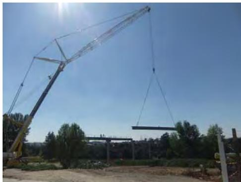
5. Démolition en place des piles et au sol des éléments de tronçons de tablier et évacuation
