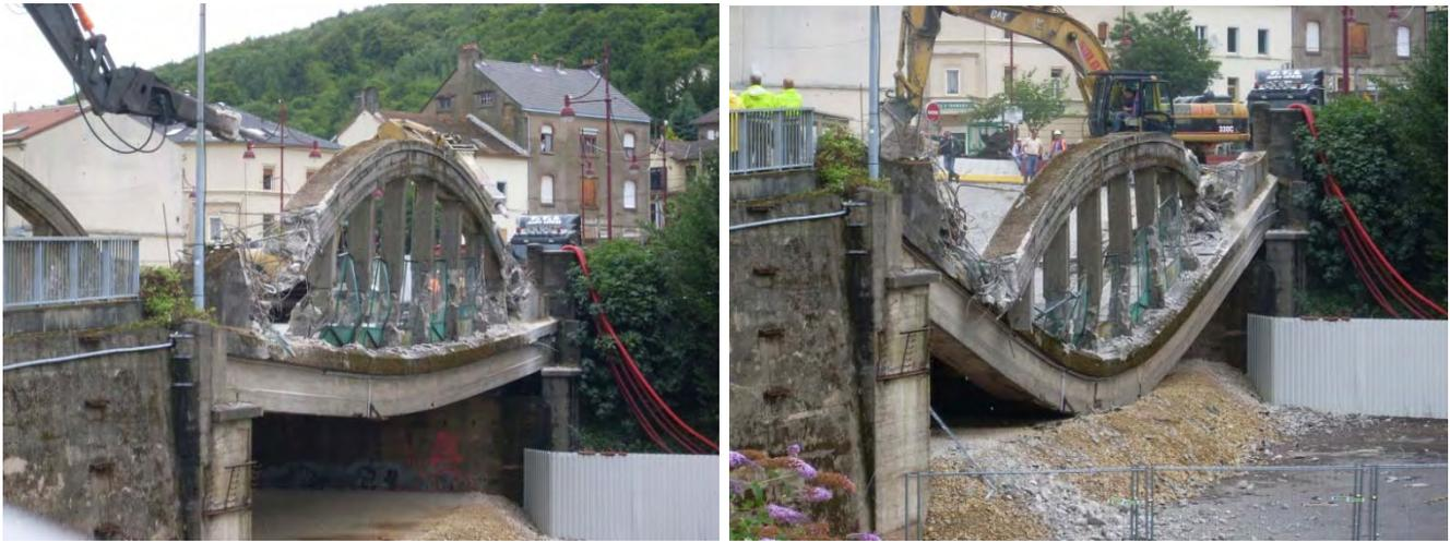
4. Poursuite de la démolition sur place. Réduction des matériaux. Tri entre ferraille (destiné à la filière acier par four électrique) et déchets de béton (destiné aux graves de recyclage GRB).
