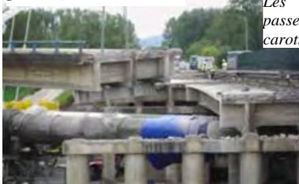
Ph 9 : les cales d'appui permettent de dégager rapidement le palonnier. Les élingues de levage passent à travers de carottage dans le hourdis.
