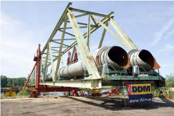
Ph 5 : l'ouvrage est descendu, déplacé et avancé (via des chaises à galet (ph 6)) vers une zone disponible et réservée pour la découpe.
