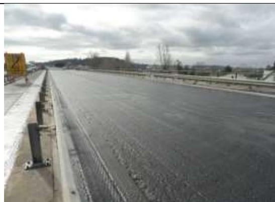
Membrana impermeabilizante de la superficie del tablero.
