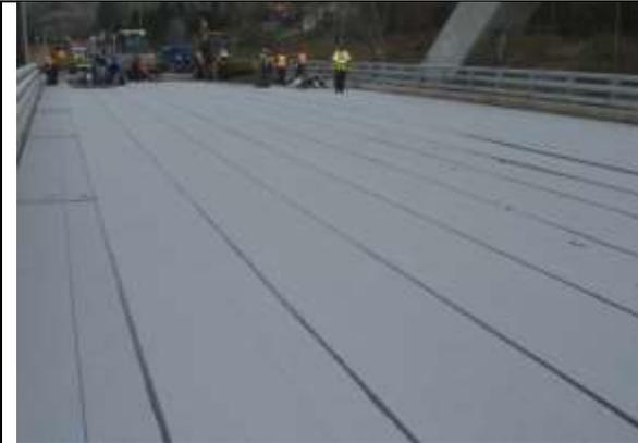
Membrana impermeabilizante termofusible.
