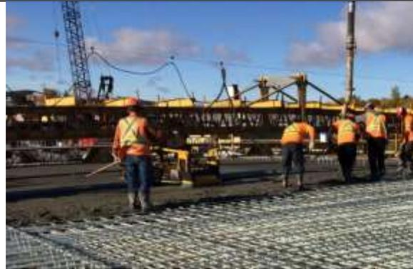
Máquina de hormigonado para el acabado de la superficie de los tableros de los puentes.
