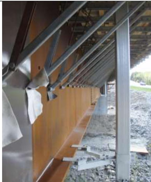
La gárgola o tubo de desagüe se extiende más allá del nivel inferior de la viga.
