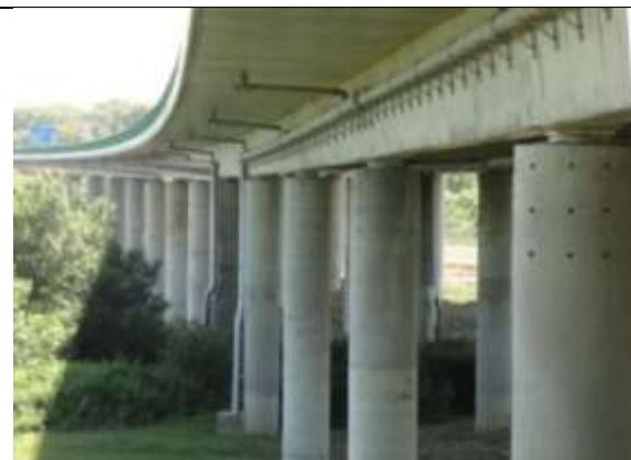
Parte superior de las pilas adaptada para recibir la plataforma para los trabajos de mantenimiento en los apoyos.
