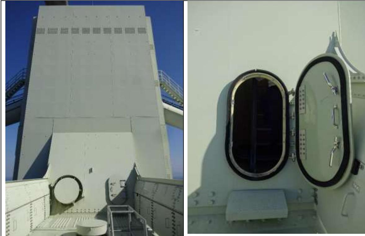
La escotilla original para entrar en el interior del hueco de la torre era de chapa de acero, sin embargo, pesaba demasiado para abrirla y podía estar corroída por la sal marina. El material de la escotilla se sustituyó por una placa de plástico reforzado con fibra de vidrio.
