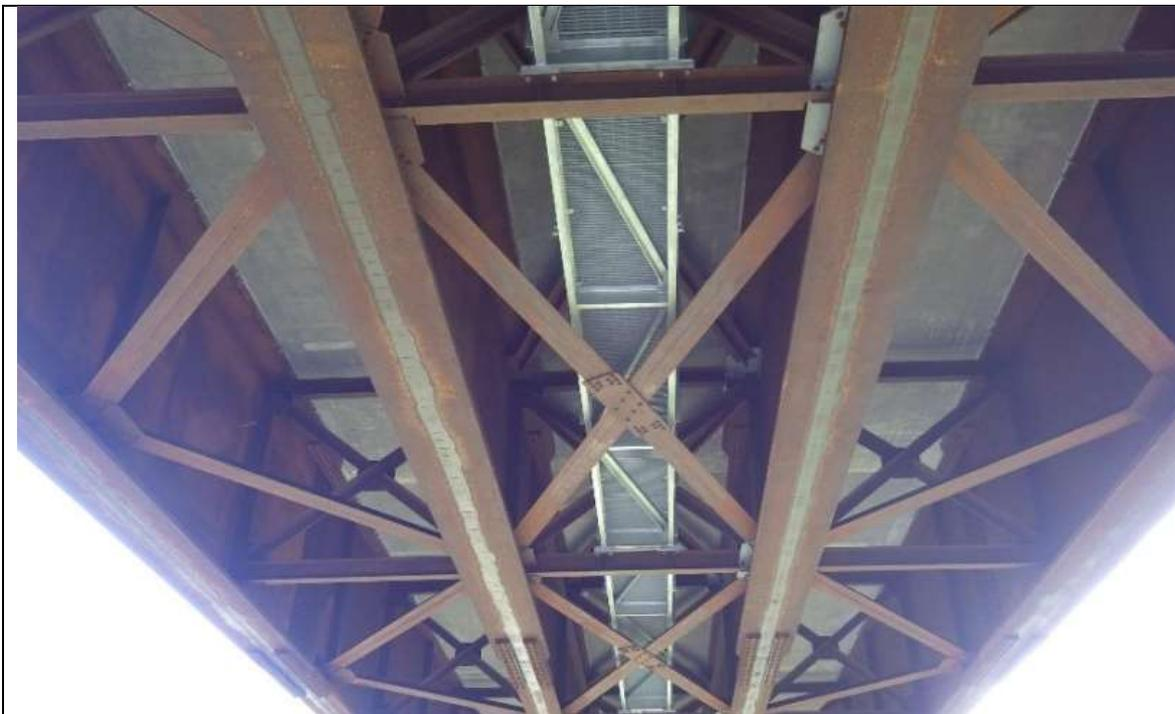
Aperturas de inspección en elementos huecos de hormigón. Pasarela de inspección para vigas y acceso a pilotes, ya que el puente es largo y alto sobre el terreno.
