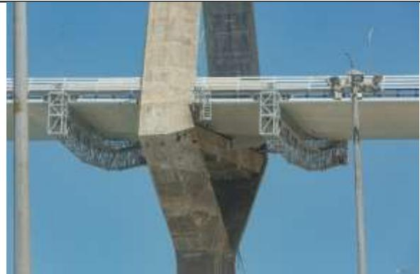
Las plataformas utilizadas originalmente durante la construcción de los vanos atirantados del puente, para operaciones de soldadura y otras, se mantuvieron como plataformas móviles permanentes.
