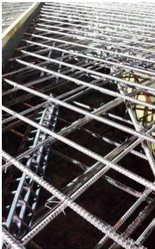
Uso de barras de acero inoxidable en las losas de cubierta.
