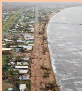
Antes de la reconstrucción
