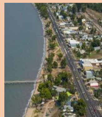
Después de la reconstrucción
