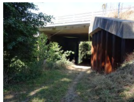
Illustration 1 : Exemple d'ouvrage après réalisation – Source : Cerema.
