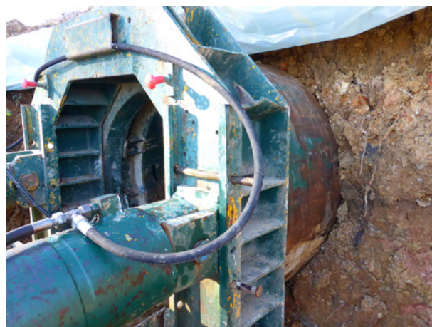
Illustration 12 : Vue sur l'élément de découpe du remblai
