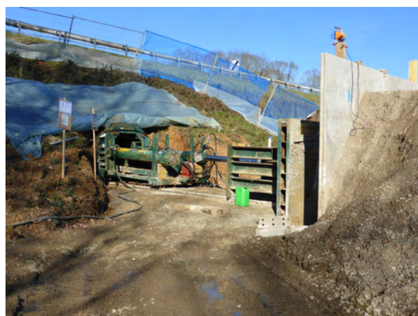
Illustration 10 : Vue sur le dispositif de poussée
