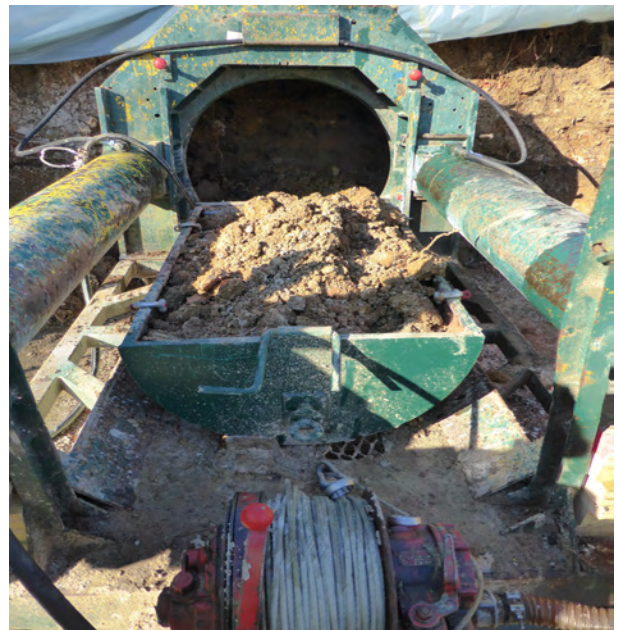
Illustration 14 : Vue sur le chariot d'évacuation des déblais
