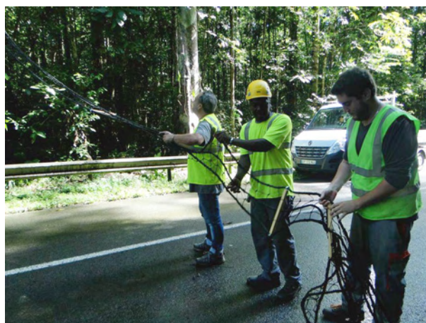
Illustration 8 : Montage du pont de singe – Source : Biotope.
