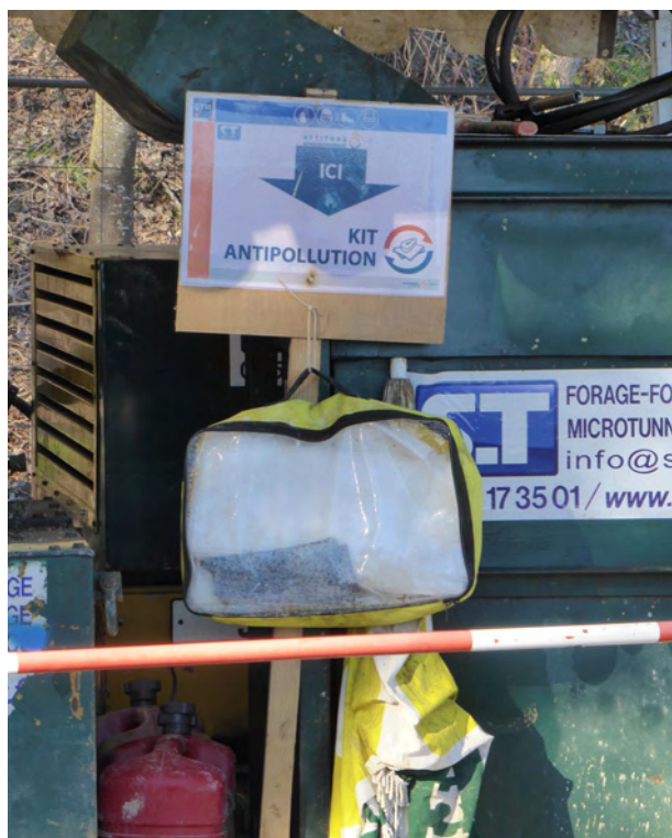
Illustration 17 : Gestion environnementale du chantier.
