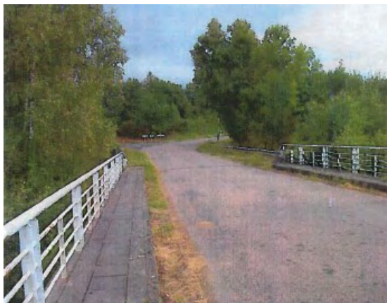
Illustration 6 : Passage supérieur avant réalisation Source : Sanef/SAPN.
