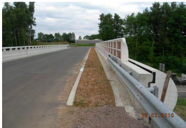
Illustration 7 : Passage supérieur après réalisation (bande enherbée et dispositif occultant) – Source : Sanef/SAPN.
