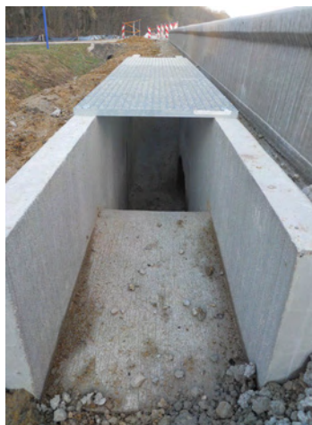
Illustration 6 : Rampe d'accès à pente douce – Crédit : C. Hervé.
