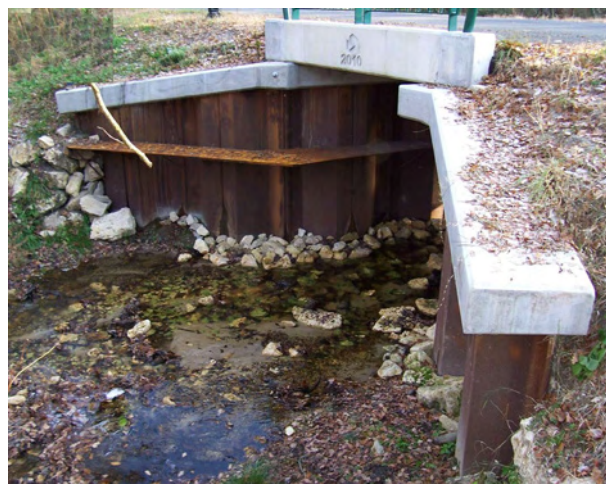
Illustration 5 : Pont de Luas, aval après travaux. Crédit : Cerema – Marc Gigueux.
