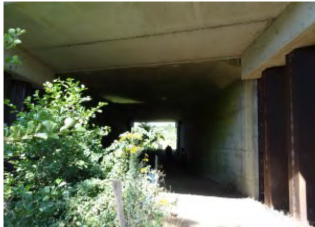
Illustration 8 : Passage mixte après élargissement Source : Sanef/SAPN.
