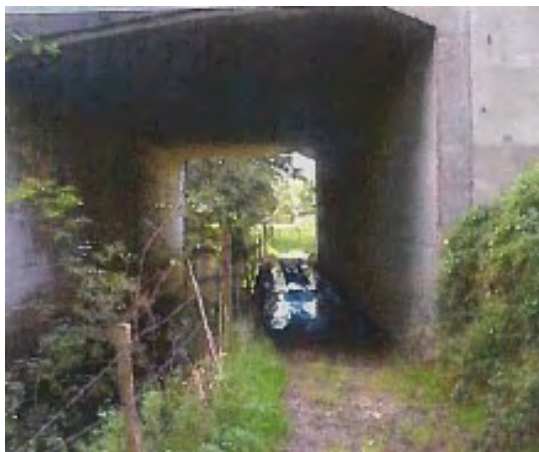
Illustration 9 : Passage mixte avant les travaux Source : Sanef/SAPN.
