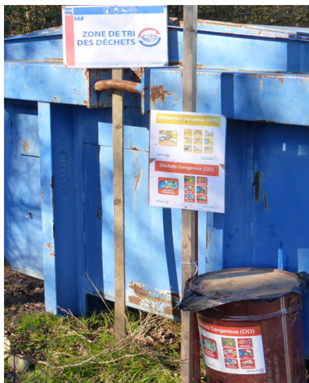
Illustration 18 : Gestion environnementale du chantier.
