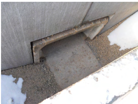
Illustration 8 : Traversée sous chaussée Crédit : C. Hervé.
