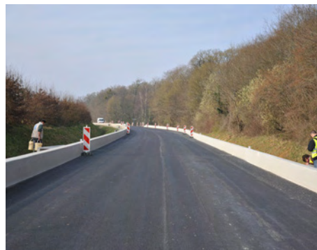
Illustration 1 : Photo de l'ouvrage lors de sa construction, 2012 – Crédit : D. Persyn.
