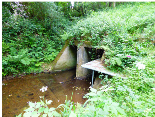
Illustration 7 : Vue sur l'amont de l'ouvrage Crédit : Cerema – J.-F. Bretaud.
