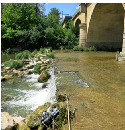
Illustration 5 : Vue sur le seuil – Source : SNCF Réseau.
