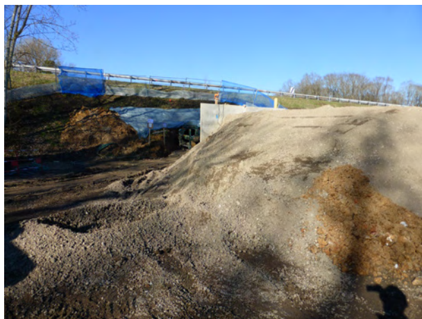
Illustration 11 : Vue sur le contrepoids de poussée
