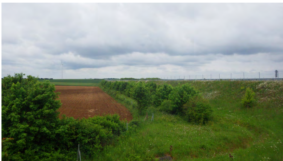
Illustration 6 : Vue d'ensemble avec la nouvelle clôture faune placée en sommet de remblai et de l'ensemble de la dépendance verte du DPAC jusqu'aux cultures – Crédit : Cerema – Christophe Pineau.
