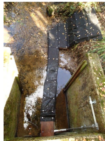
Illustration 15 : Vue sur l'amont de l'ouvrage – Source : Grege.
