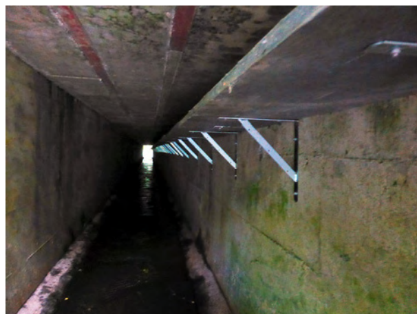
Illustration 8 : Vue sur la banquette en encorbellement – Crédit : Cerema – J.-F. Bretaud.
