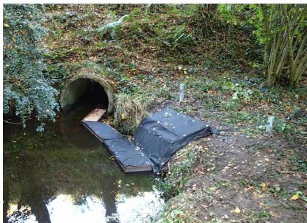
Illustration 14 : Vue aval de l'ouvrage – Source Grege.
