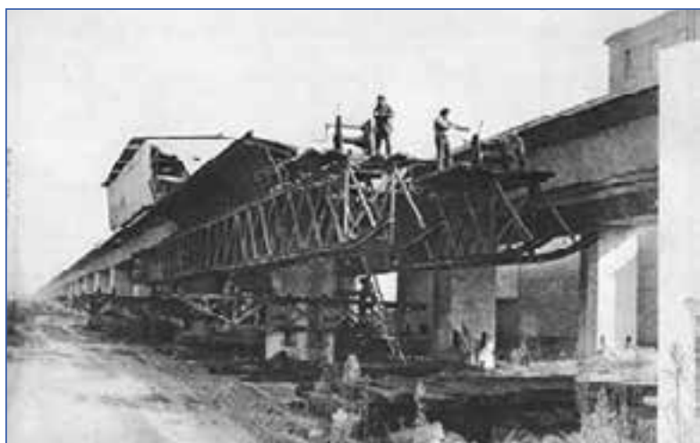
Foto 5. Supresión de un paso a nivel en Gerona (1973). Proyecto de Carlos Fernández Casado. Contratista: UTE Dragados-Huarte. Cimbra mecanotubo, luces de 20 metros y ciclo de 6 días por vano.
