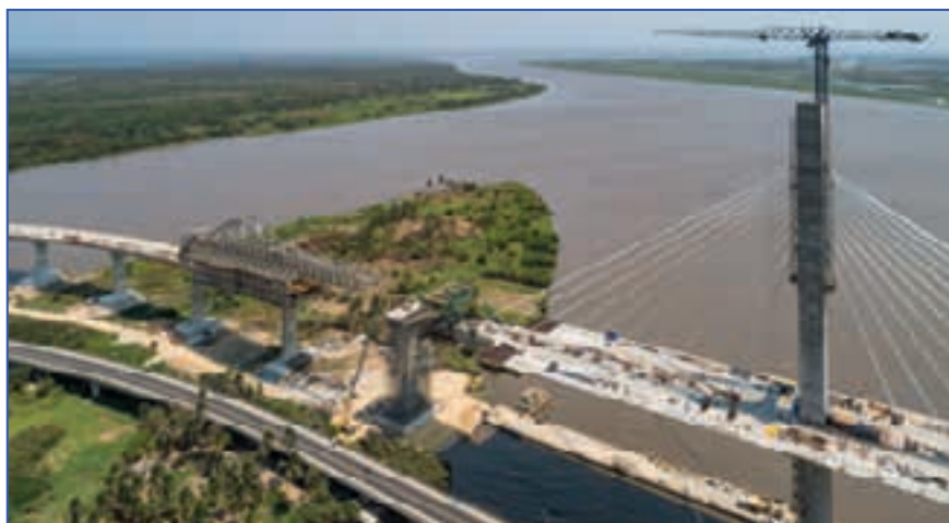
Foto 11. Puente de Pumarejo en Barranquilla (Colombia). 2019.
