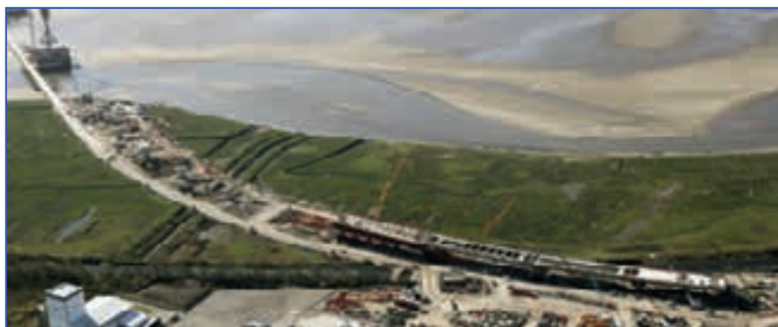
Foto 10. Viaducto de aproximación del río Mersey (Reino Unido).
