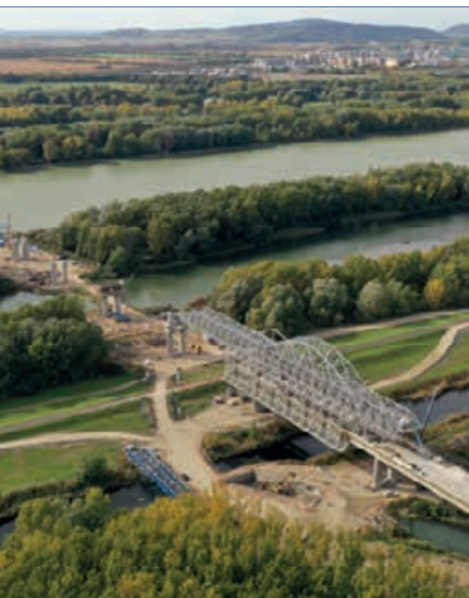
Foto 3. Cimbra autolanzable sobre tablero.
