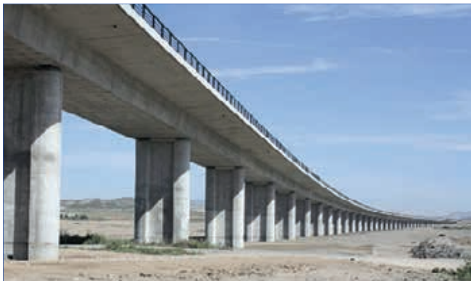
Foto 1. Las cimbras autolanzables son especialmente adecuadas para puentes con muchos vanos.
