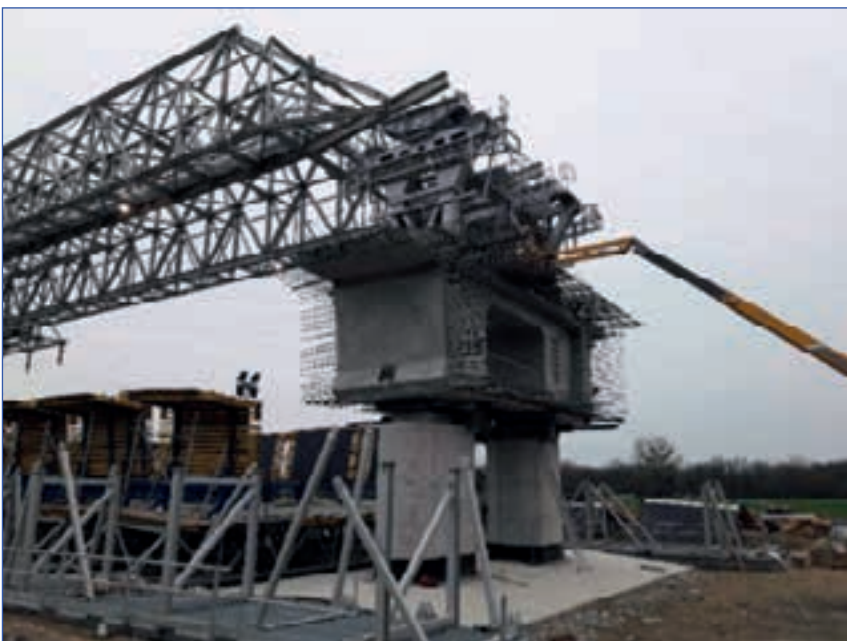
Foto 15. Dovela sobre pila previa al aterrizaje de la autocimbra.
