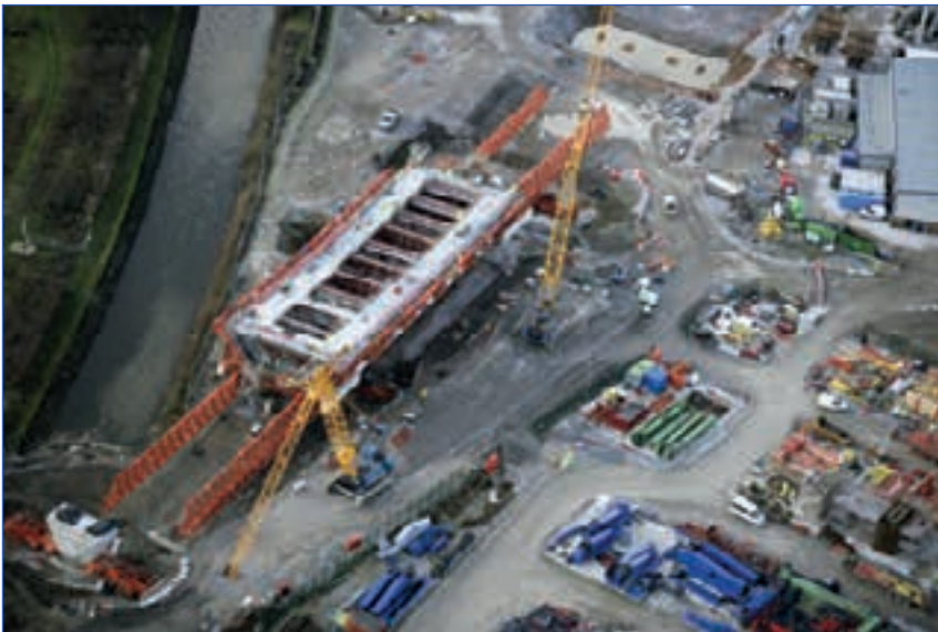
Foto 14. Faseado en hormigonado del tablero en el puente del Mersey con cimbra autolanzable bajo tablero.
