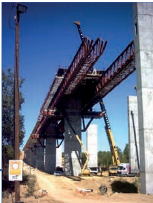
Foto 2. Cimbra autolanzable bajo tablero.
