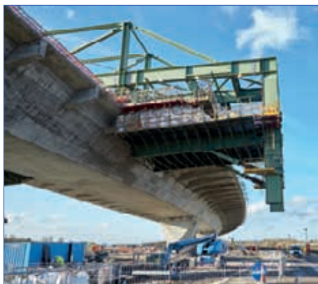
Foto 12. “Carro de alas” para prolongación de voladizos con costillas. Mersey (Reino Unido).
