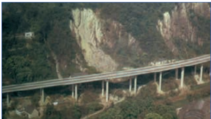
Foto 4. El viaducto Kettiger Hangbrücke (Alemania) fue construido en 1959.
