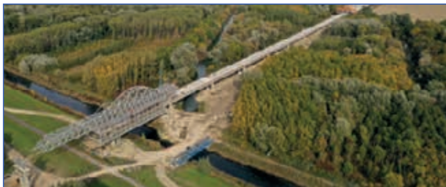
Foto 9. Puente de acceso este al Danubio, con vanos de 70 metros y 1.200 metros de longitud total.
