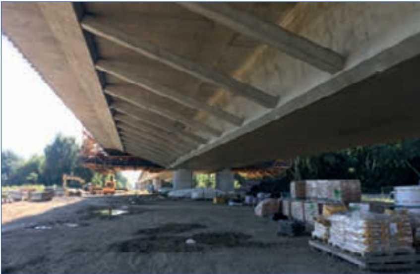
Foto 13. Prolongación de voladizos con puntales prefabricados. Viaducto de aproximación del este al Danubio.
