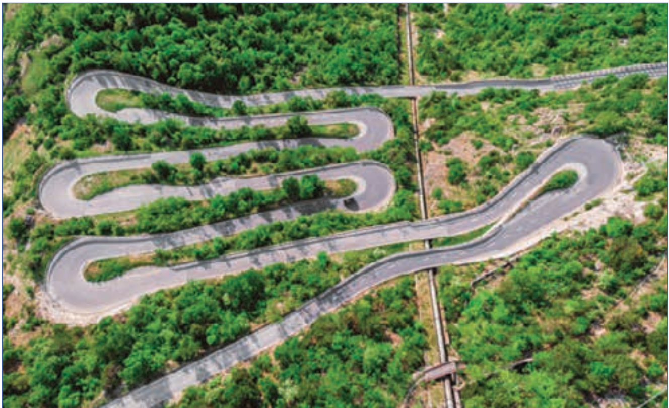
Foto 8. Imagen tomada con una aeronave no tripulada (dron) de un tramo singular de carreteras. Las cámaras con que están equipados los drones permiten leer matrículas a 1.000 metros de distancia.
