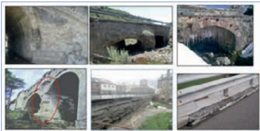
Figura 2. Deterioros típicos en elementos de hormigón en zonas de vialidad invernal importante.
