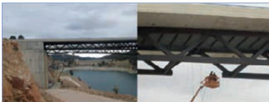
Figura 3. Rotura de cordón inferior en tablero tipo celosía metálica, en calzada de autovía.
