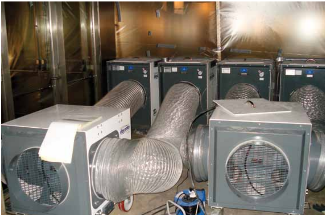
Figura 40. Verificar los equipos
