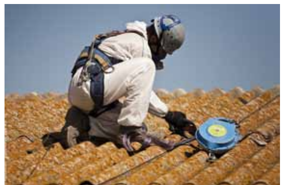
Figura 1. Trabajador en retirada de amianto
