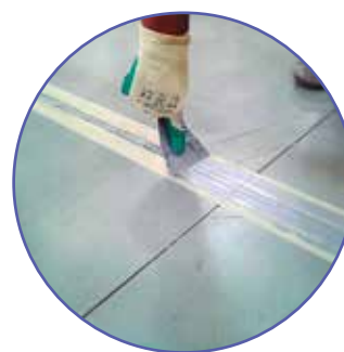
Pavimento con juntas dispuestas correctamente
